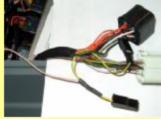
Schritt 3: rosa Kabel
